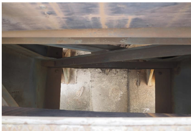
Obr.: Pohled na koncevé zavětrování a pevné ložisko na O 02
